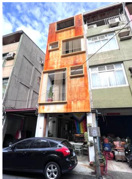
図 4-1 「阡陌一舍 UNS」外観
