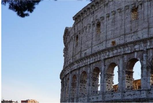
○大きき長さ 188m、幅 156m、高さ 84mで、 5万人という収容人数を誇る円形競技場。西暦 70～80 年と 10 年がかりで建設。構造に使用されている素材は火山灰を利用したコンクリートブロック。力学的に安定しているため鉄筋、鉄骨を使用せずとも現在までこの円筒形を維持しています。
